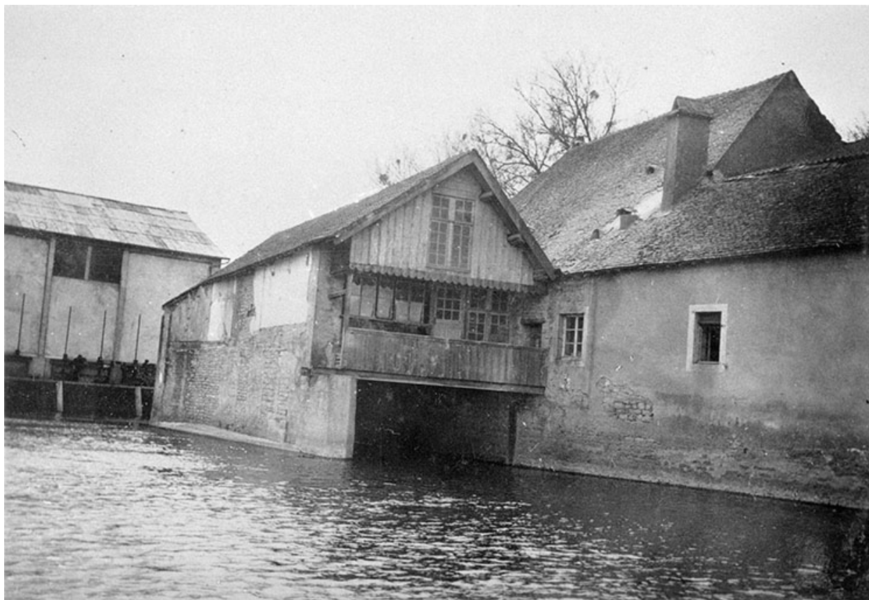
Moulin. Côté canal d'amenée.
