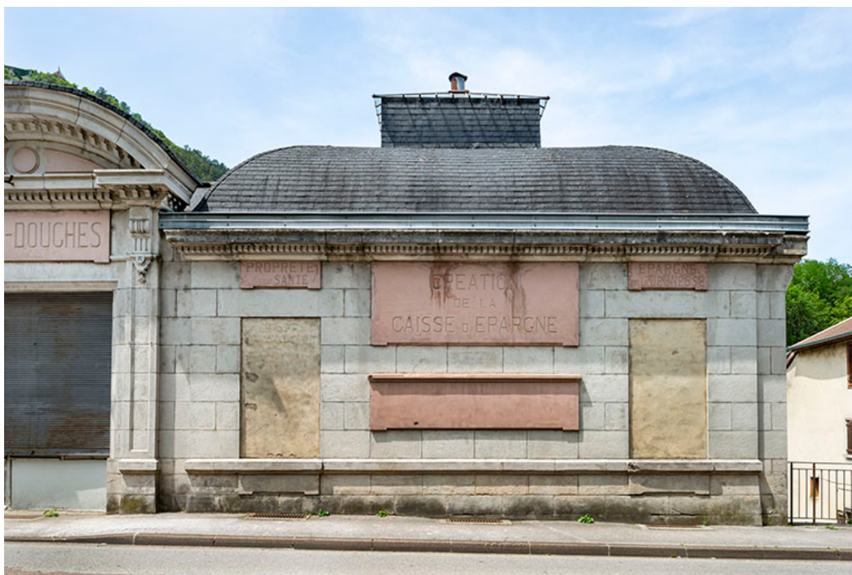
Elévation sur rue du pavillon nord.
