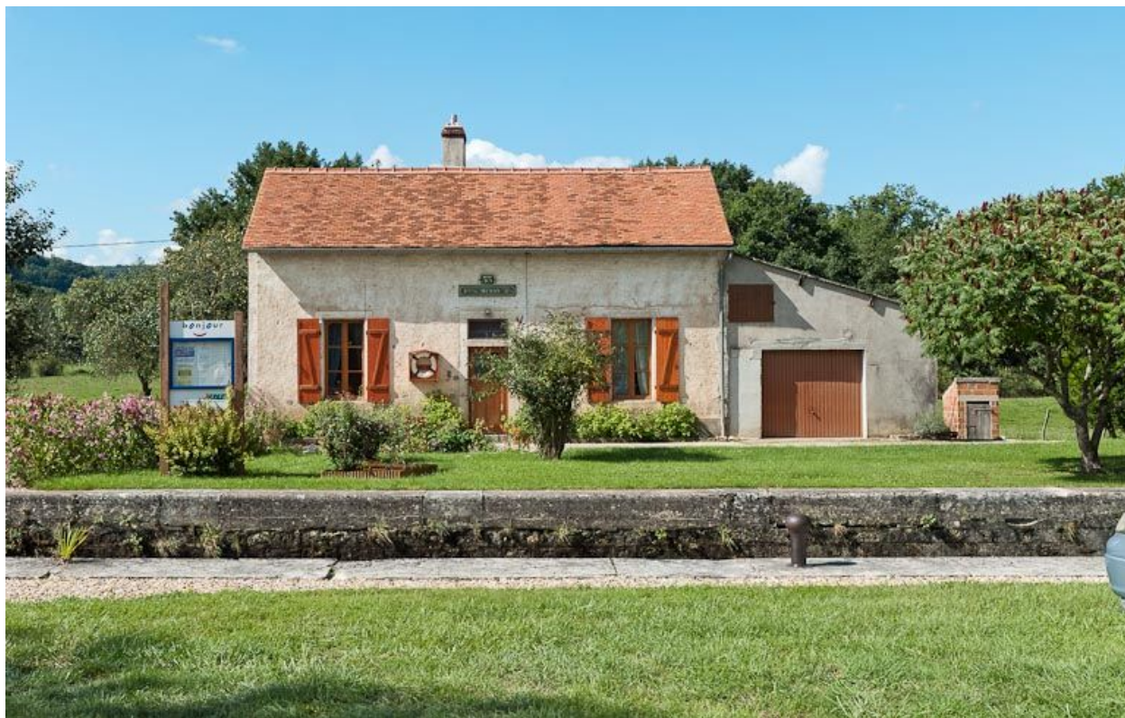
Vue de face de la maison éclusière.
