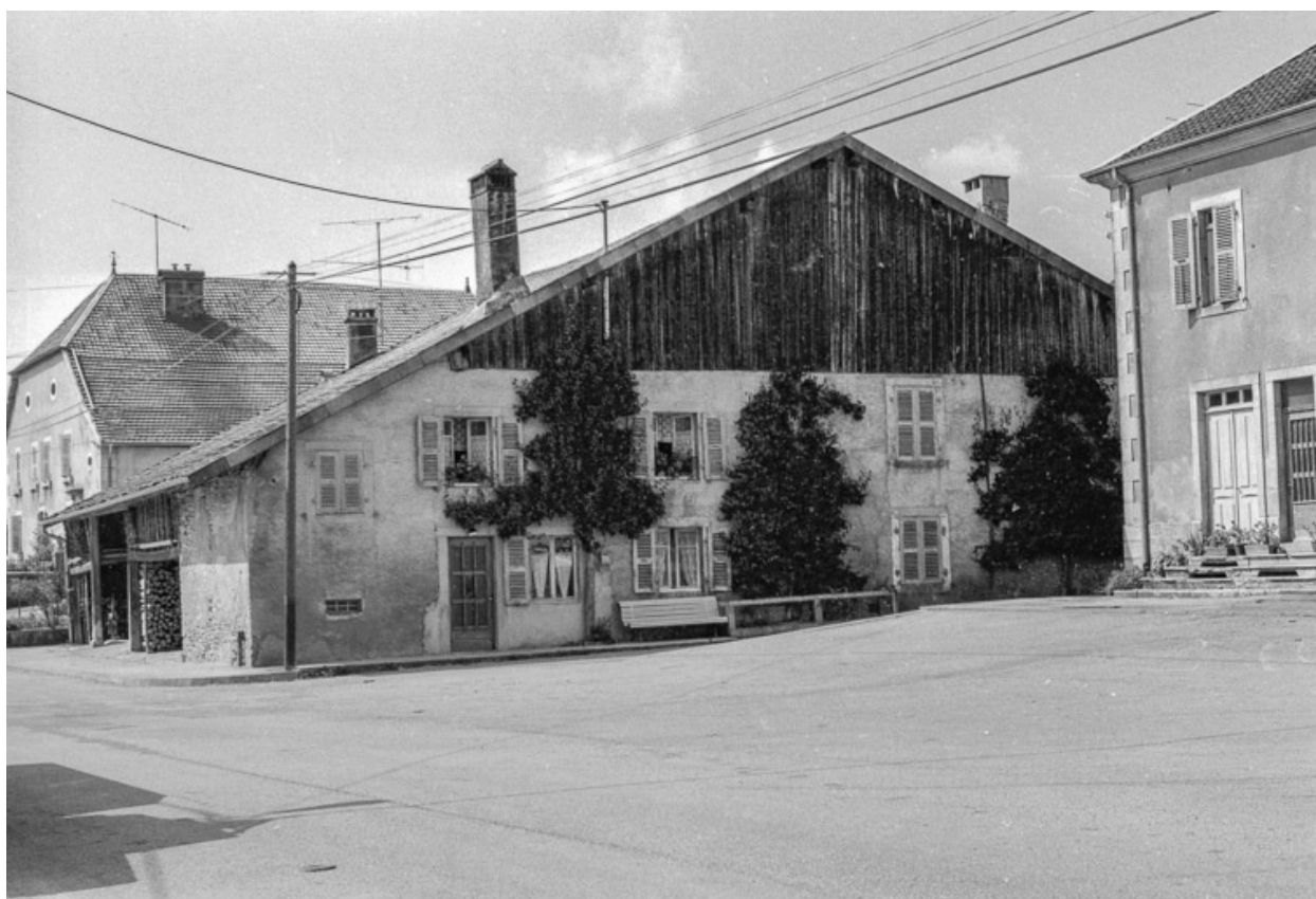
Façades antérieure et latérale droite.
