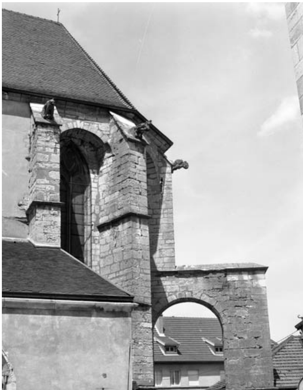
Chevet : détail des contreforts partie droite.
