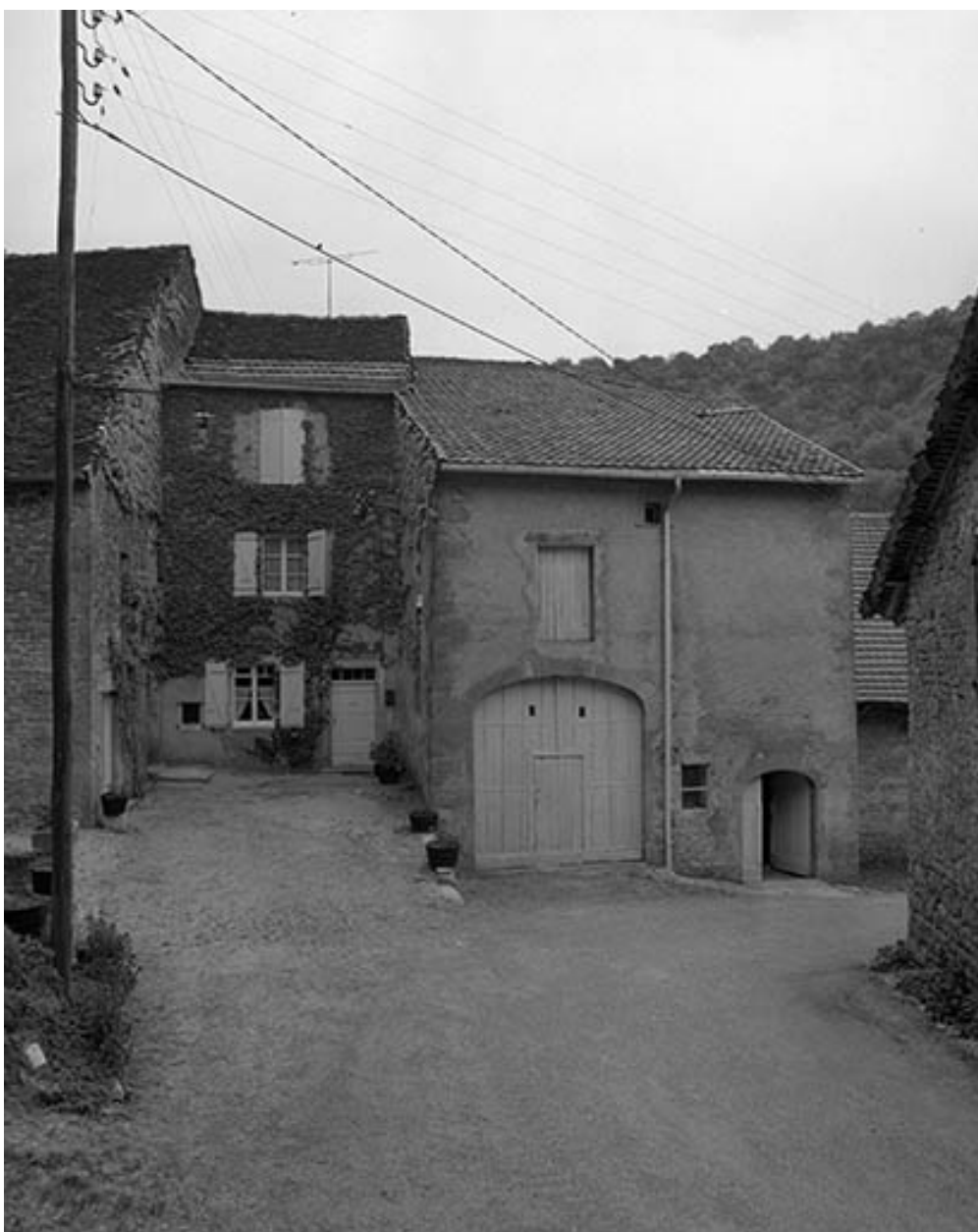
Ferme située rue du Fond de Vau.
