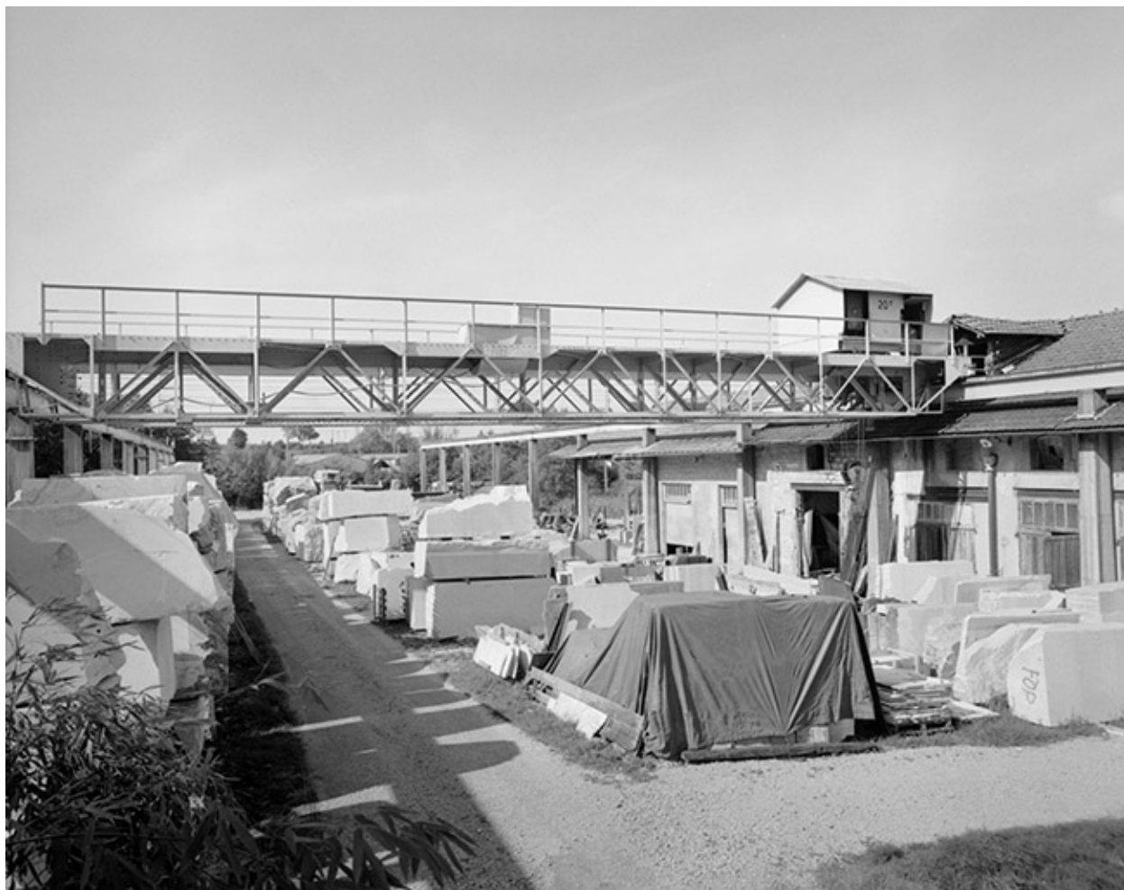
Atelier de fabrication et pont roulant.
