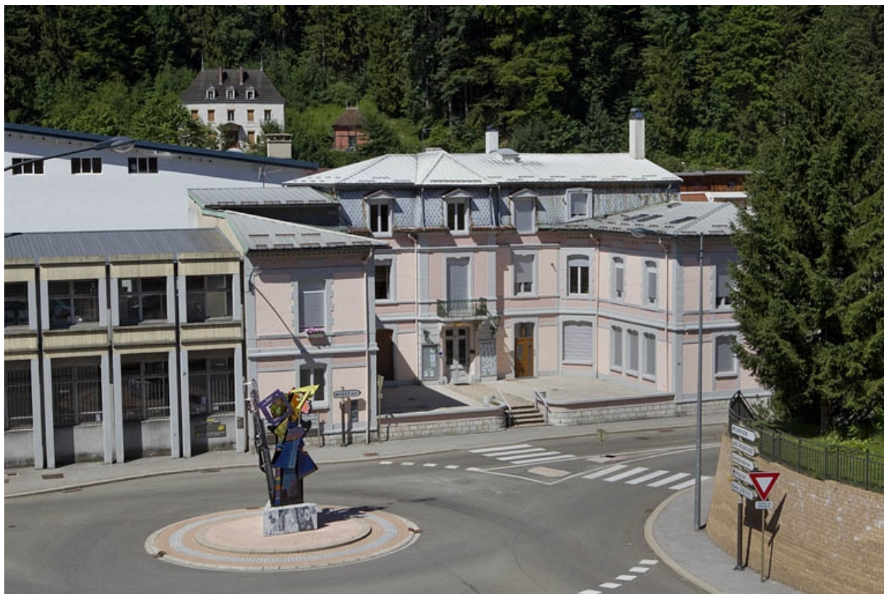
Vue d'ensemble plongeante, depuis l'est.
