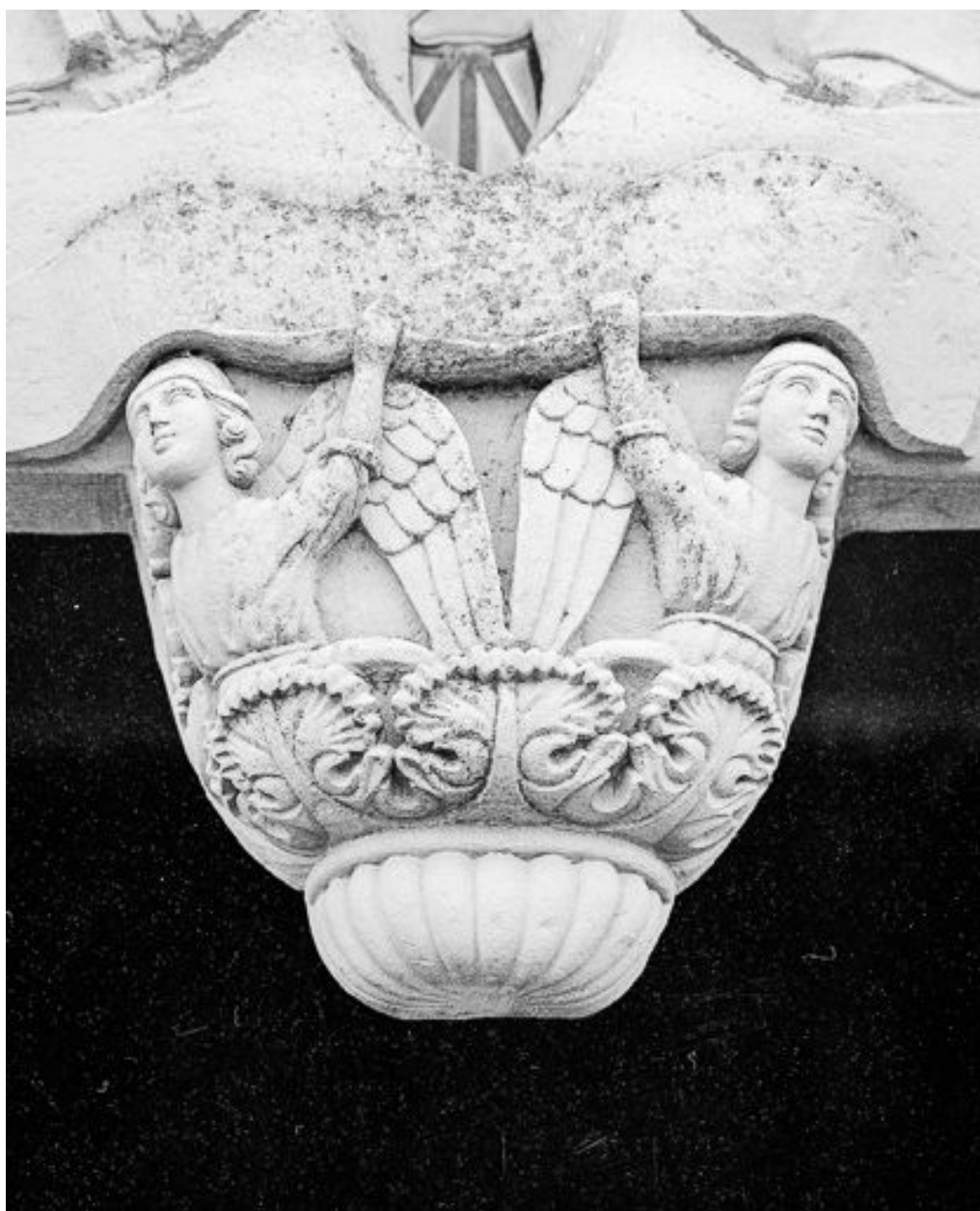
Extérieur : portail, façade antérieure, détail.
