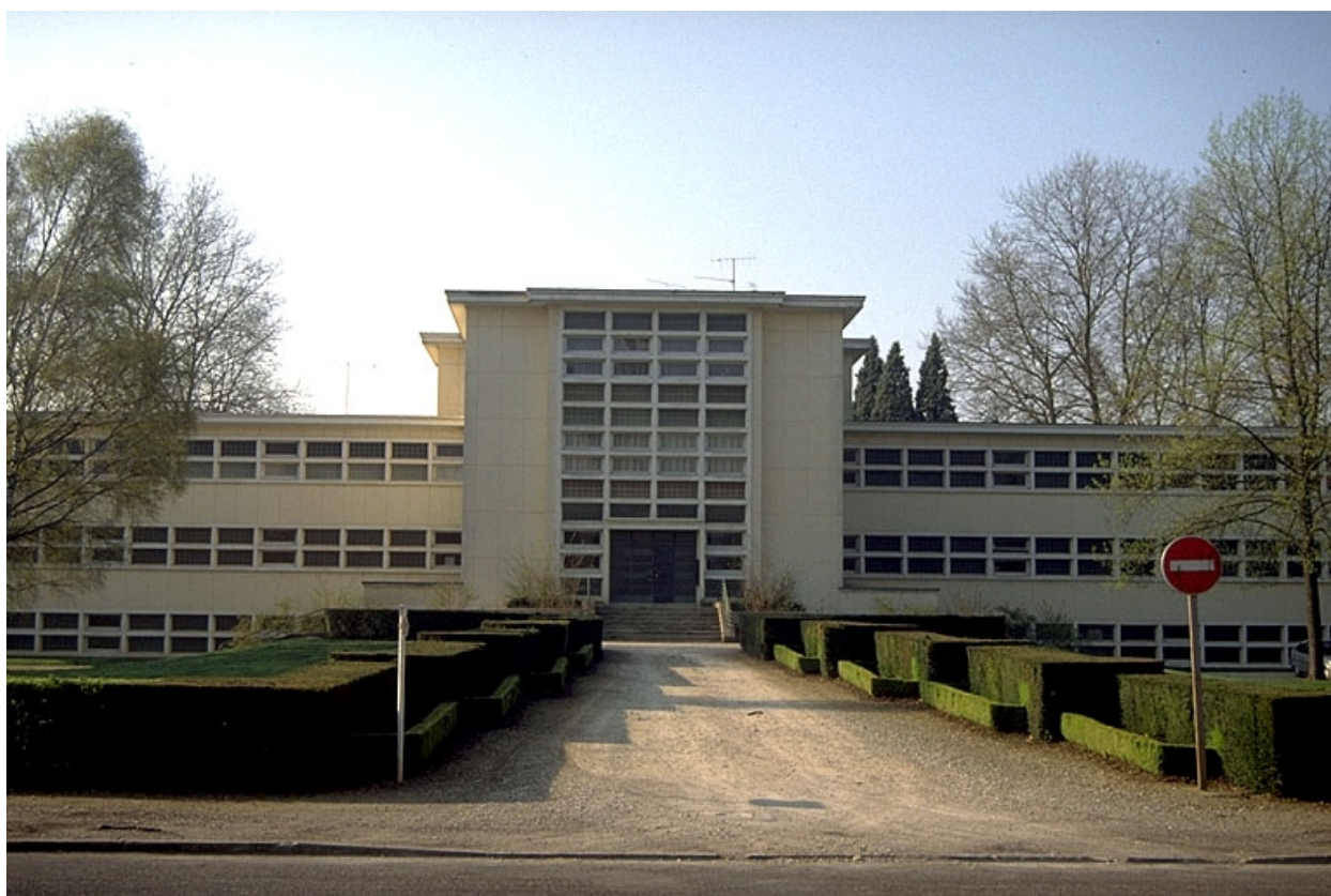
Façade antérieure, vue de face.
