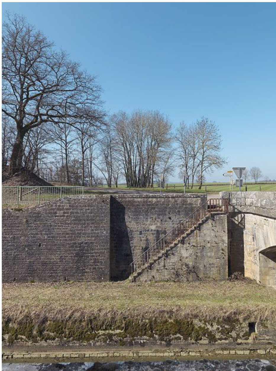
Escaliers d'accès au pont.
