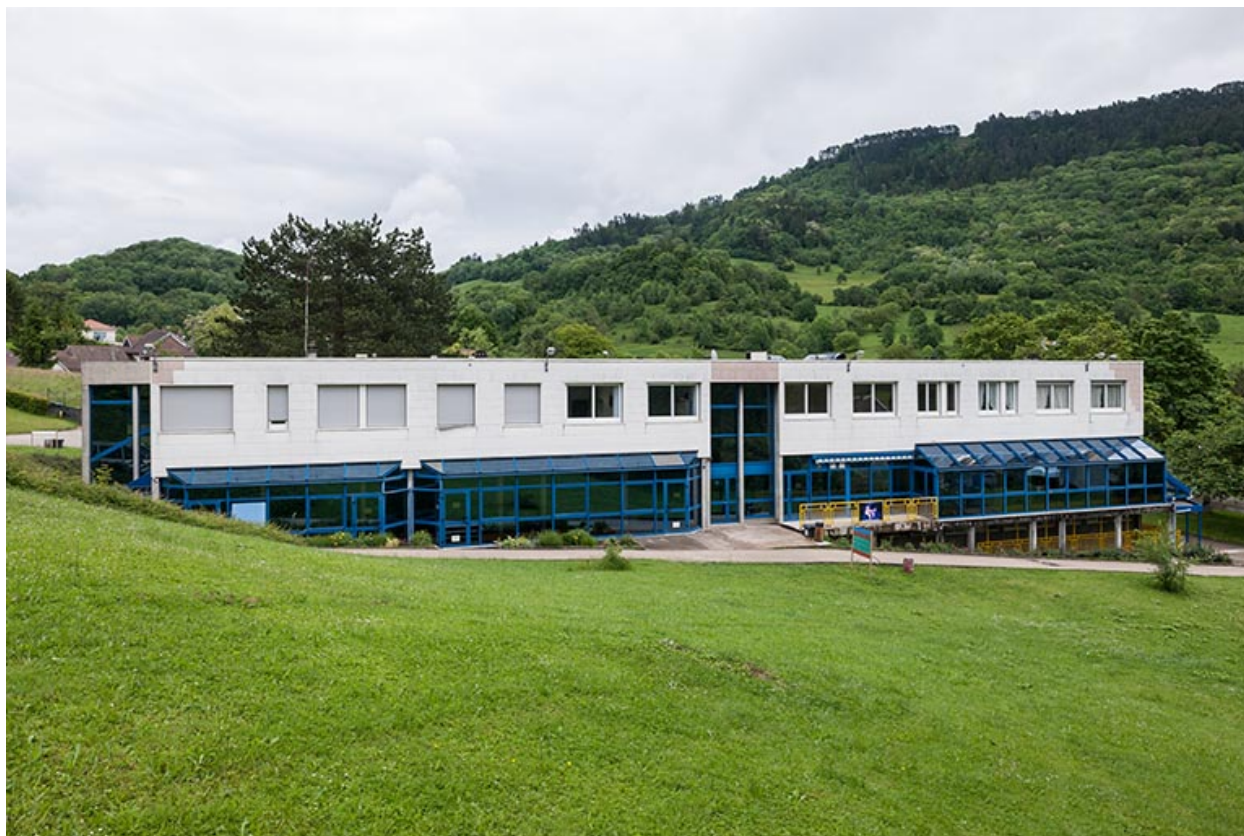
Façade antérieure occidentale de la restauration.
