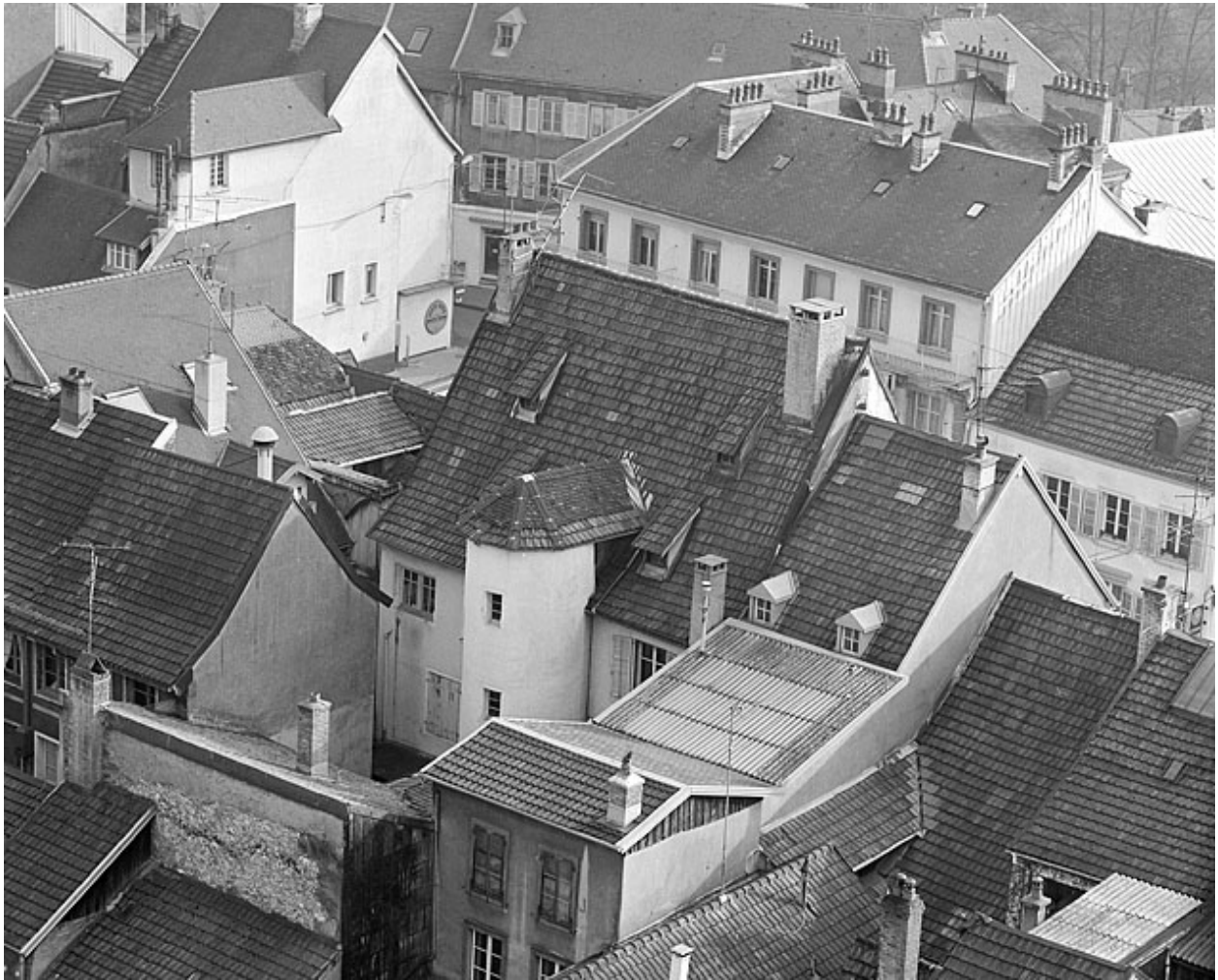
Vue d'ensemble des toitures.
