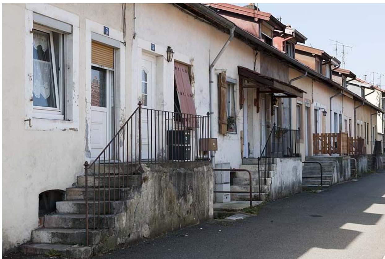
Façade nord sur la rue des Cités.
