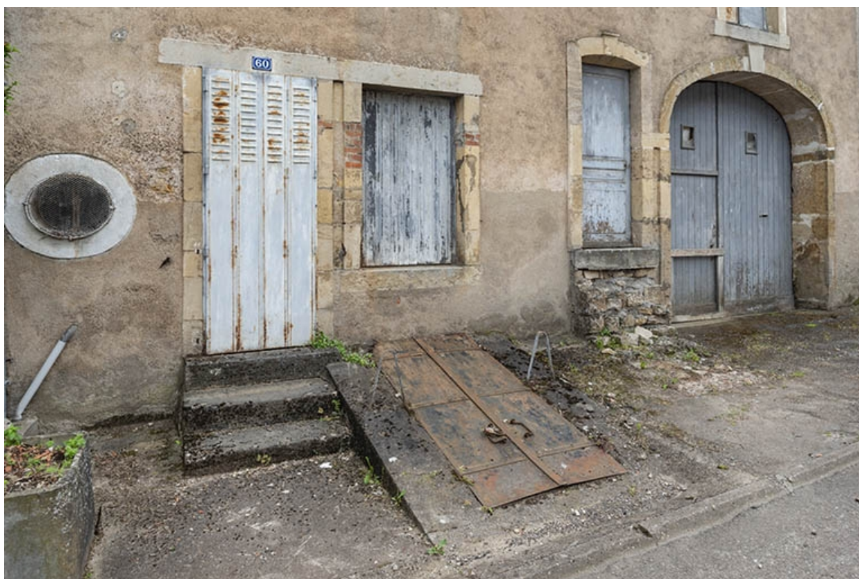
Rue Thiers, rez-de-chaussée du n° 60.
