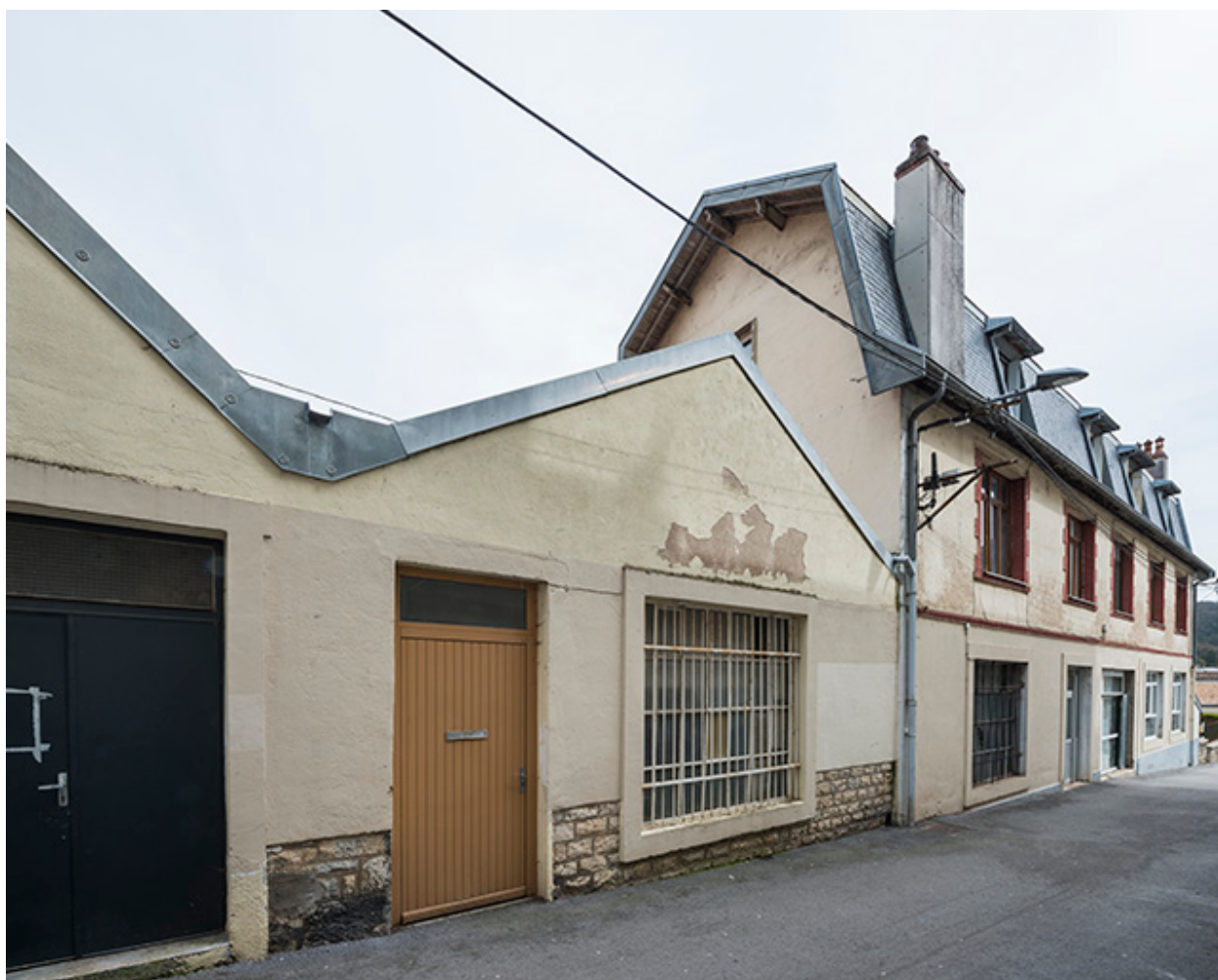
Atelier depuis le nord-ouest.
