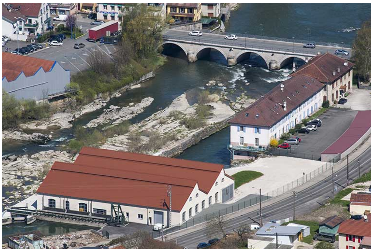
Bâtiments de bureaux en aval du site.
