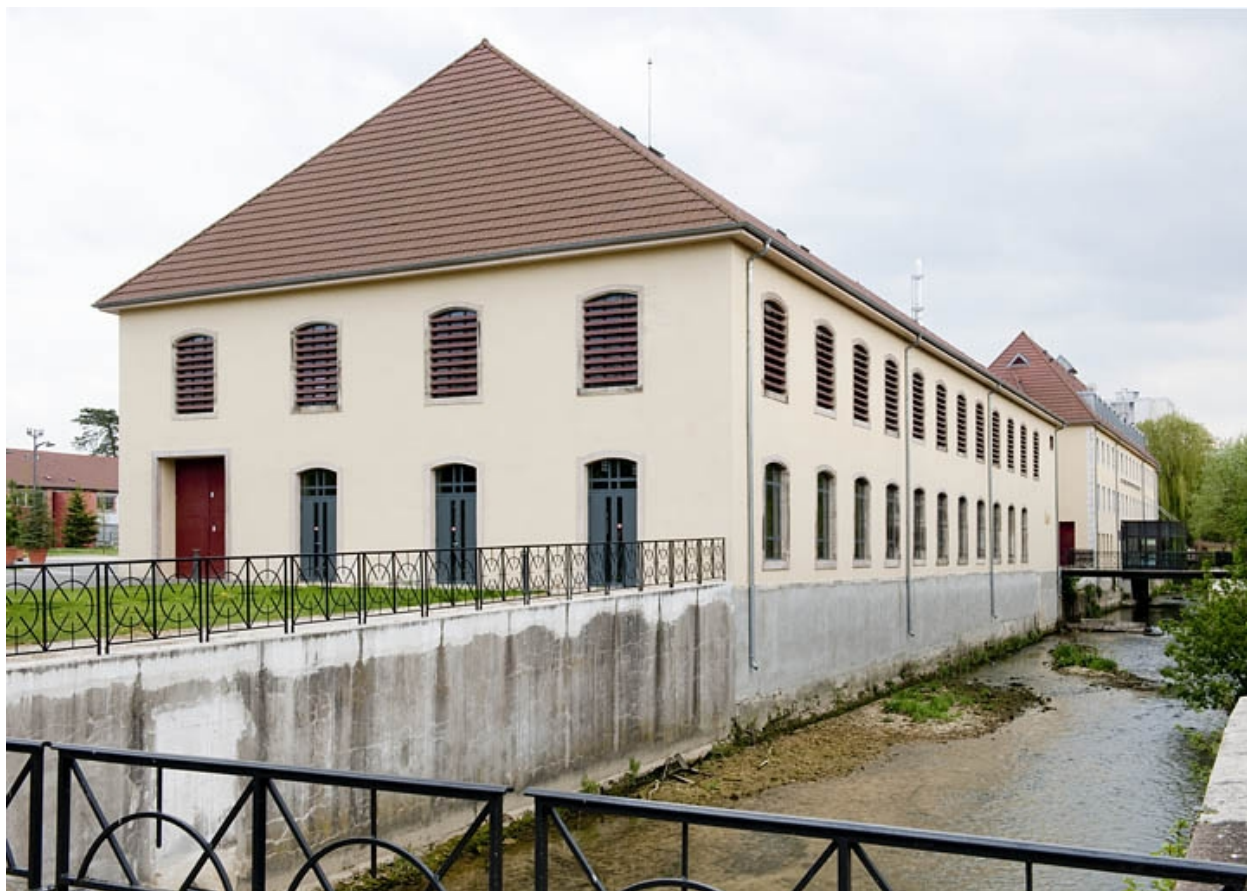
Atelier de filature nord depuis l'aval.
