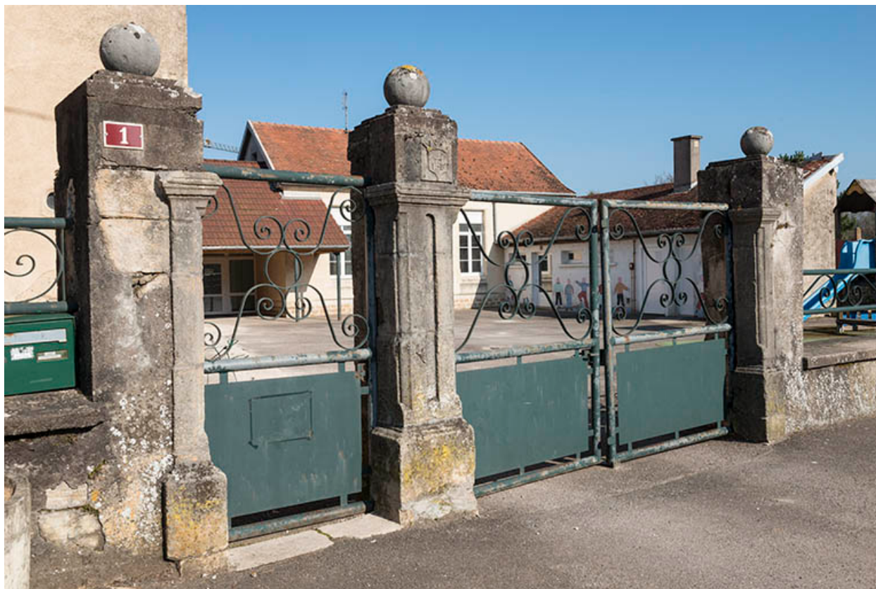
L'entrée depuis la rue.
