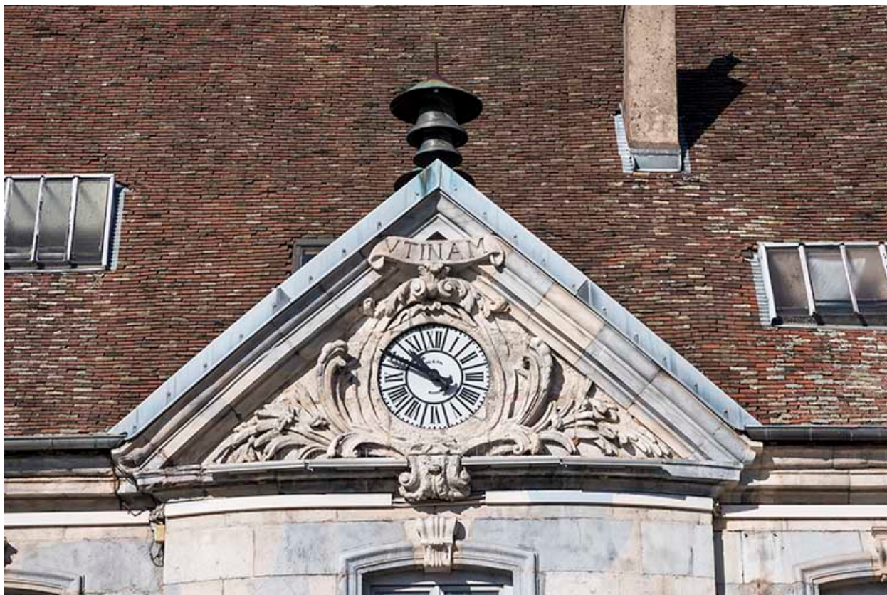
Avant-corps central : fronton.
