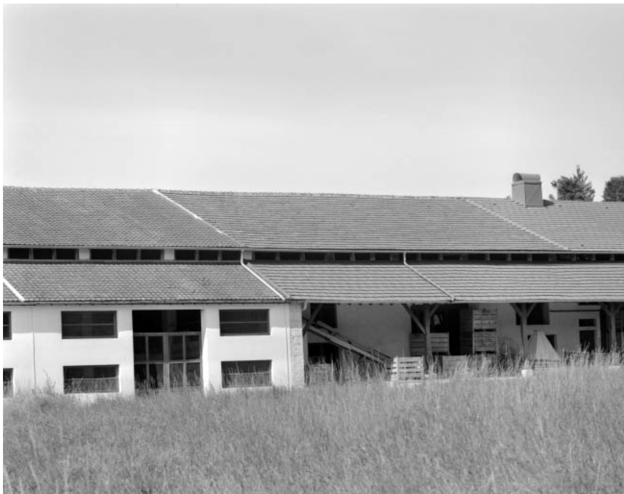
Séchoir : détail de la façade antérieure.
