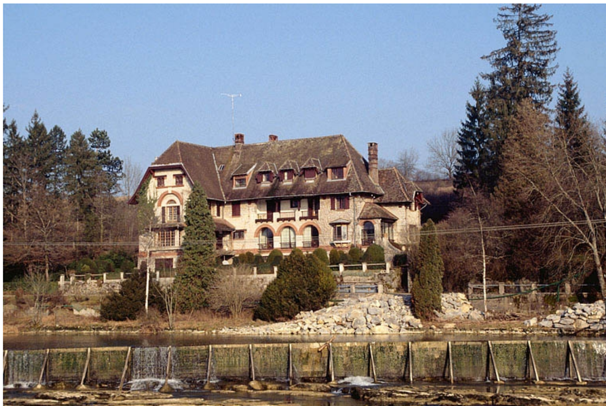
Façade antérieure du logement patronal.
