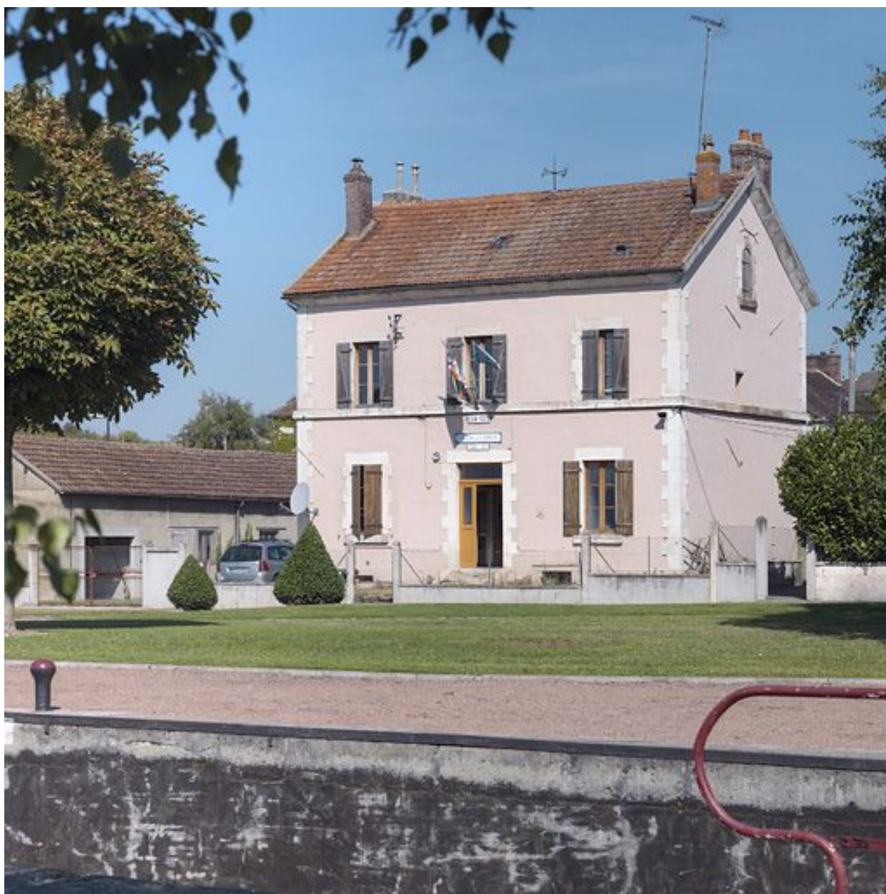
La maison éclusière et de perception de 3/4.
