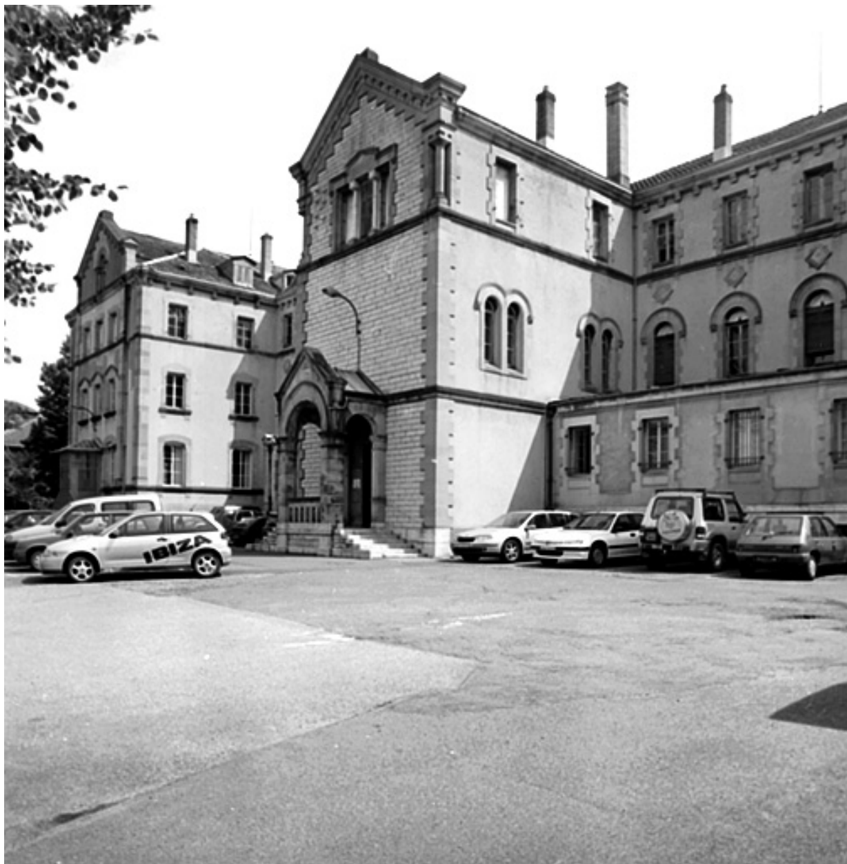
Façade antérieure de l'ancien couvent (actuellement bureaux).
