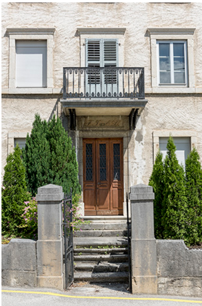
Façade antérieure : travée centrale.
