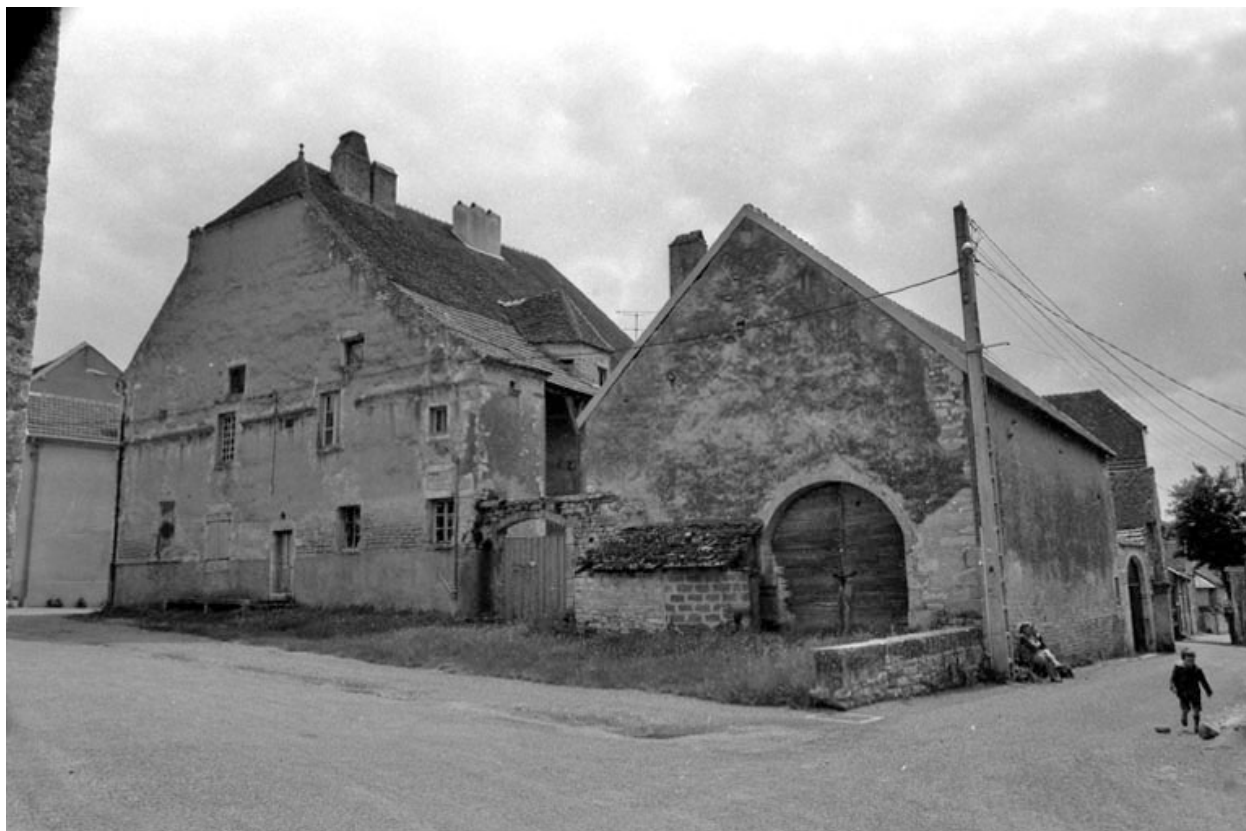
Façade latérale droite et bâtiment agricole.
