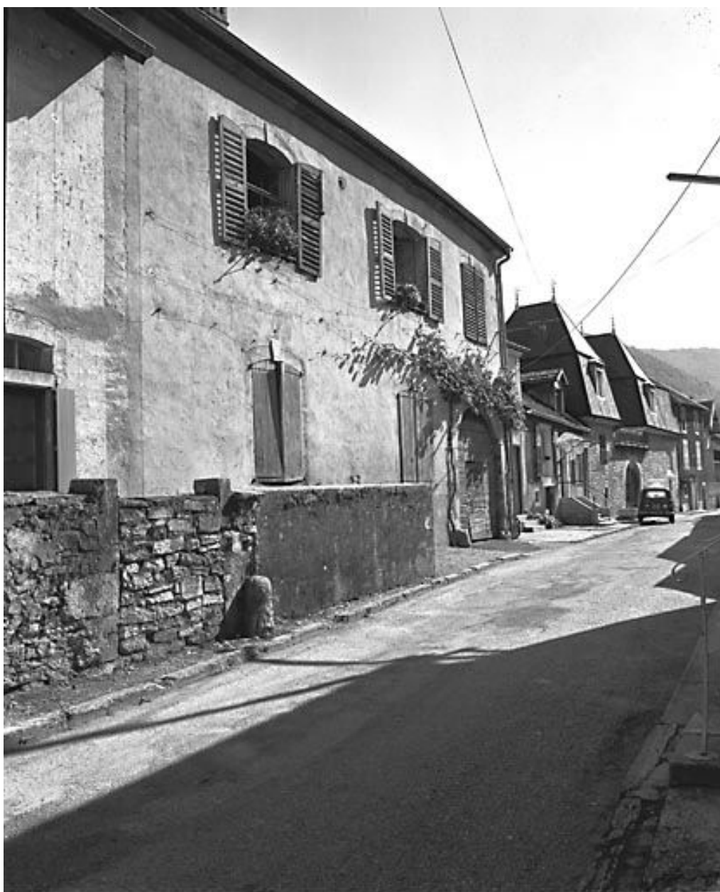
Maison de vigneron située 1 Grande Rue.
