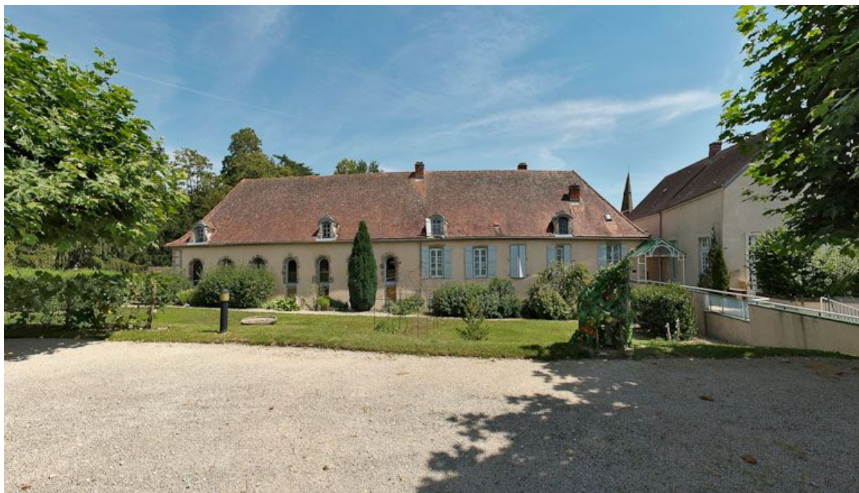
Façade postérieure de l'ancien hôpital.
