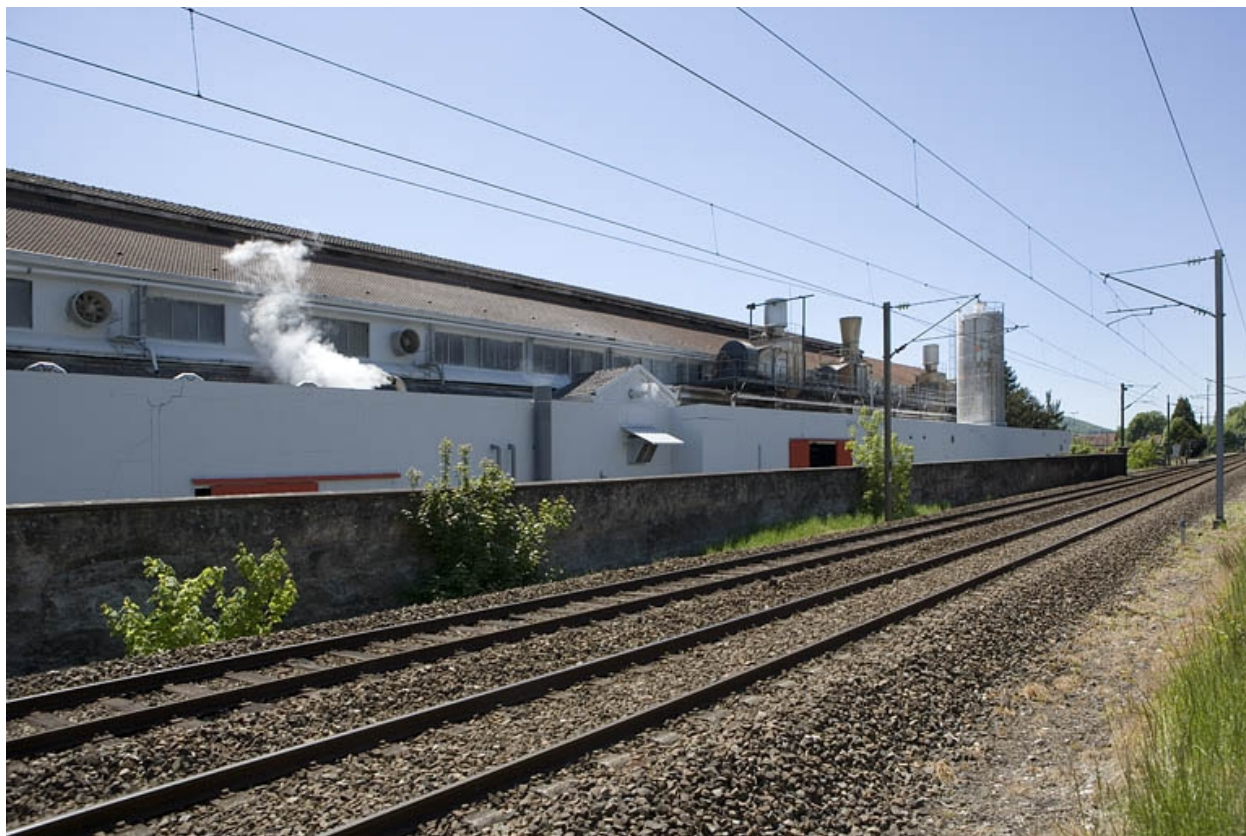
Atelier de la machine à papier. Façade nord.
