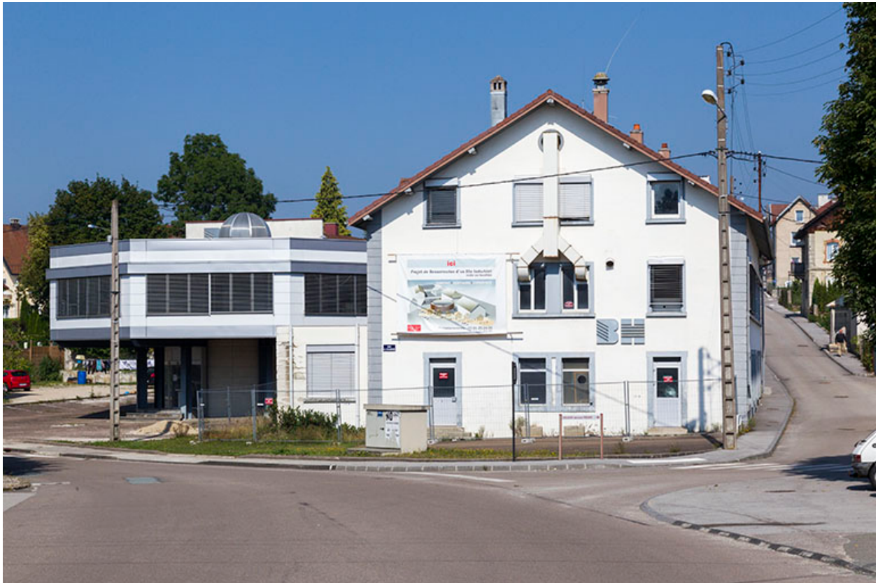
Corps d'entrée et usine, vus de l'est.
