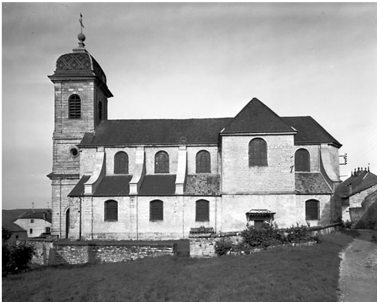
Façade latérale droite.
