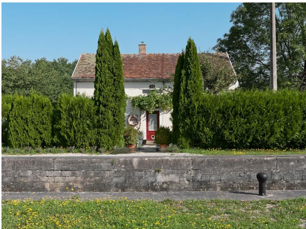
Vue de face de la maison éclusière.
