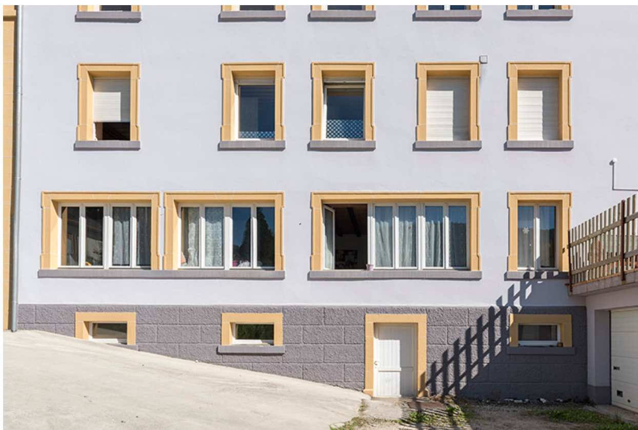
Façade postérieure : baies d'atelier.
