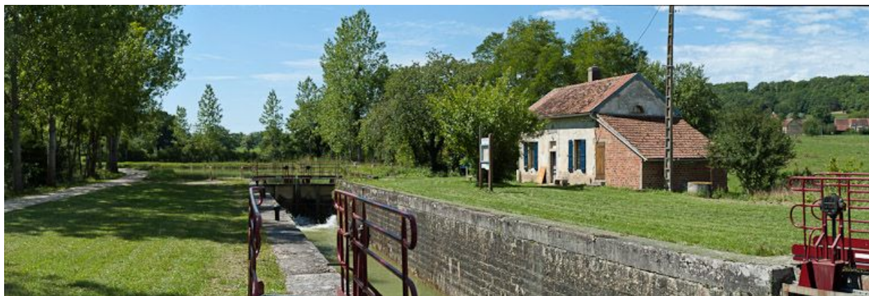
Vue d'ensemble du site d'écluse.
