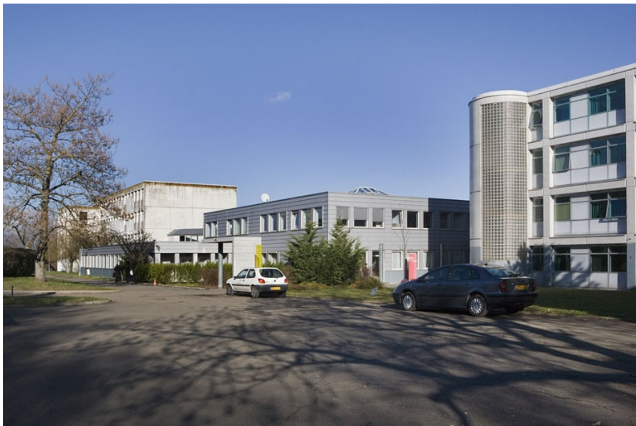
Vue d'ensemble depuis l'entrée principale.
