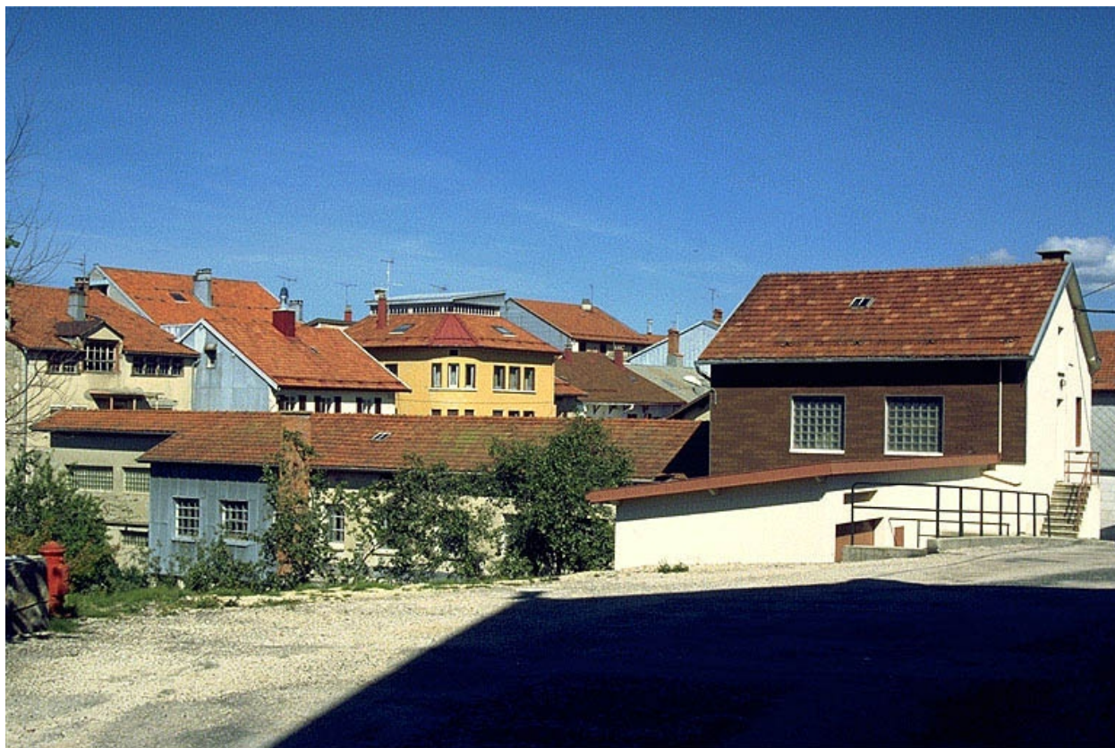
Façade postérieure de l'usine.
