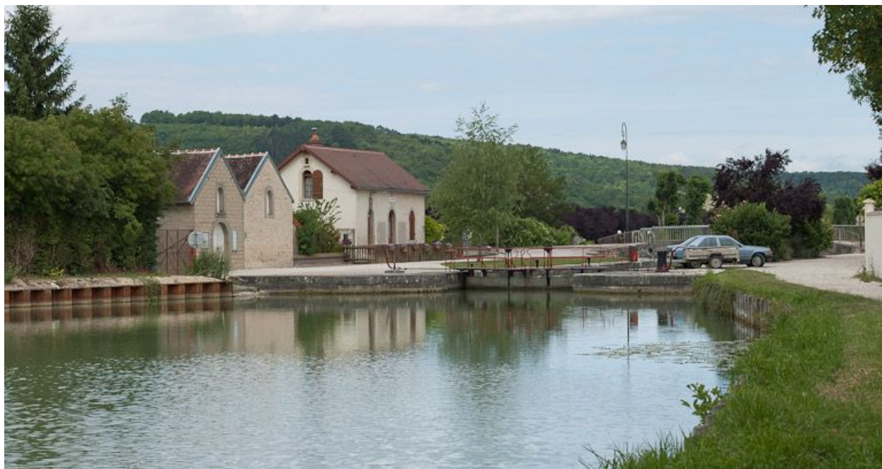
Vue du site d'écluse depuis l'amont.
