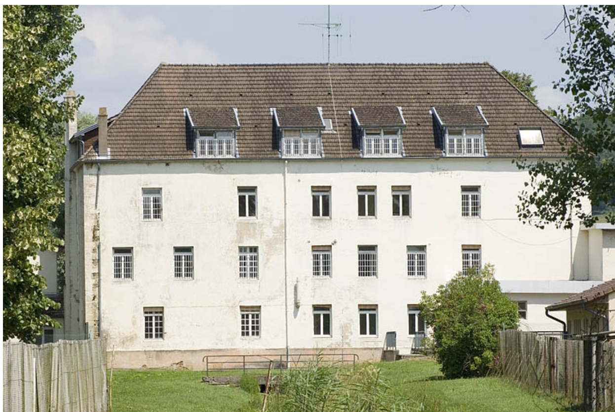
Façade postérieure depuis l'aval du bief.
