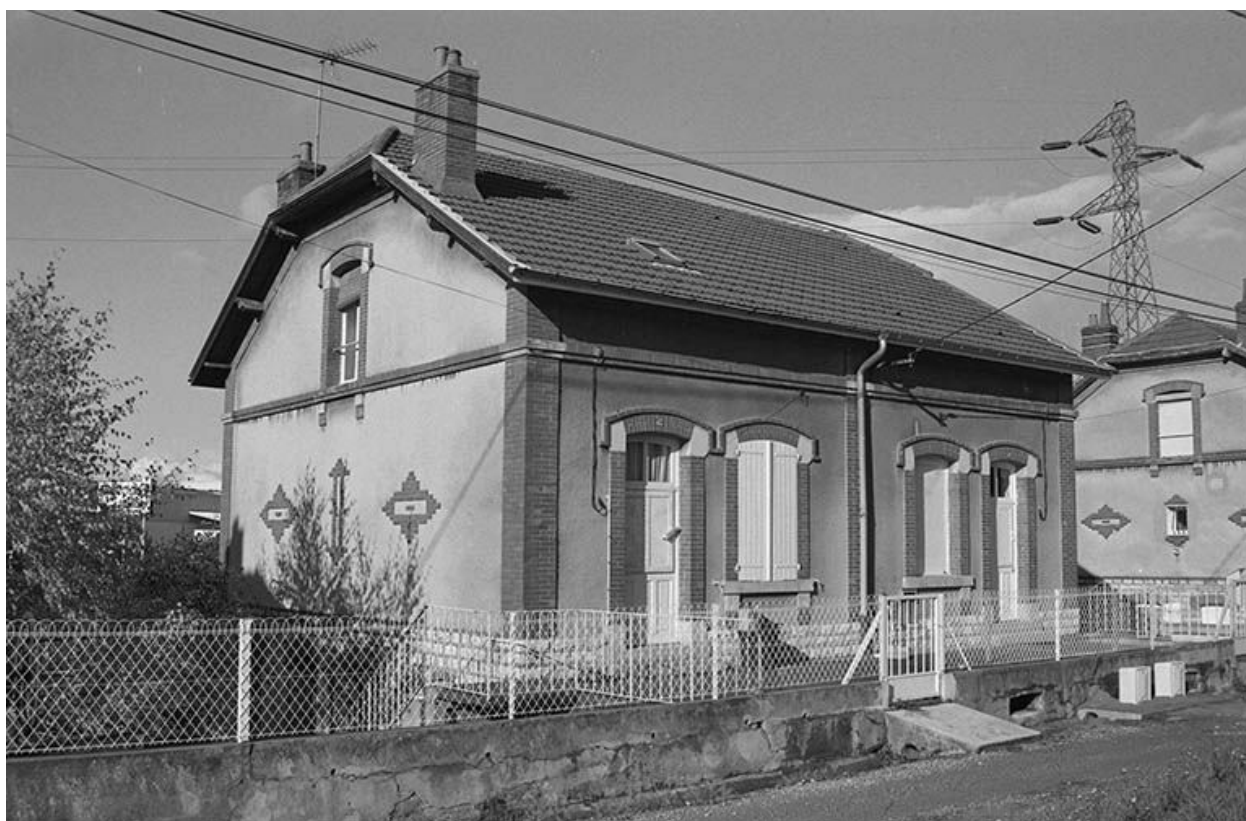
Bâtiment à deux logements ouvriers de " type 4 ".
