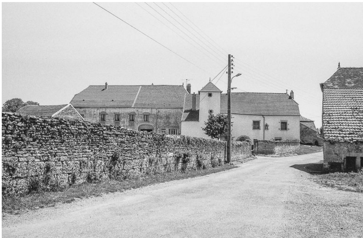
Vue éloignée du bâtiment depuis la rue.
