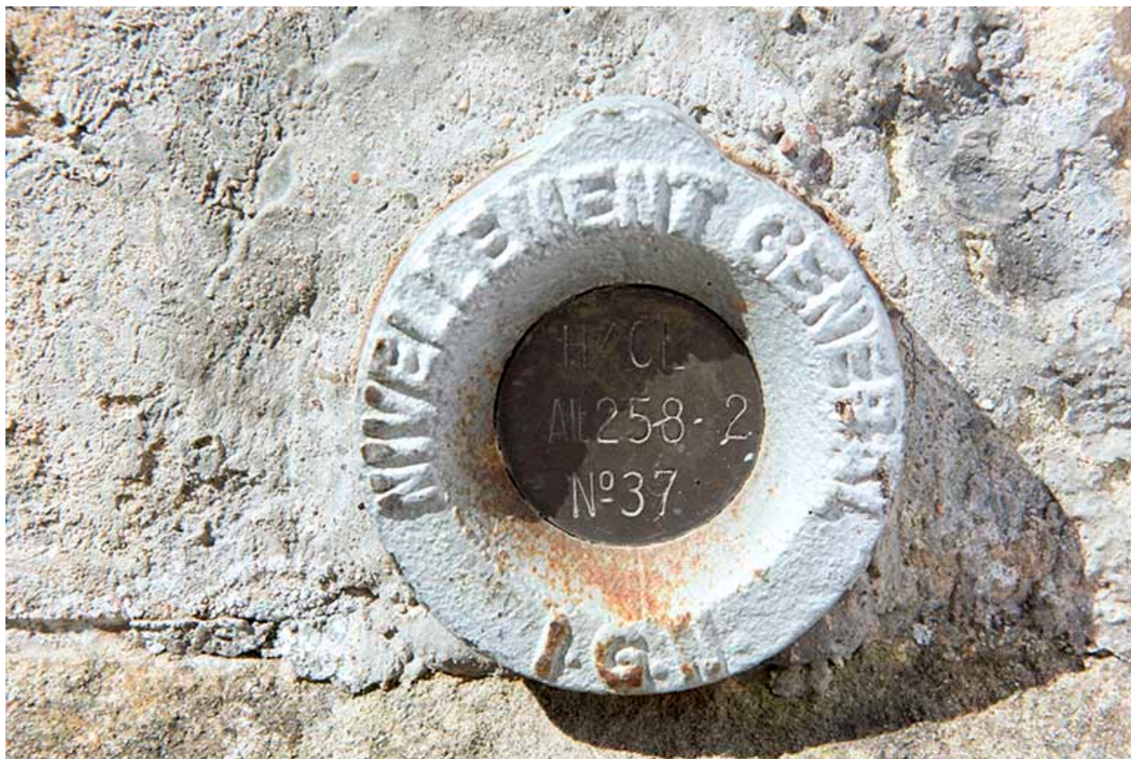
Répère de nivellement, église d'Aisey.
