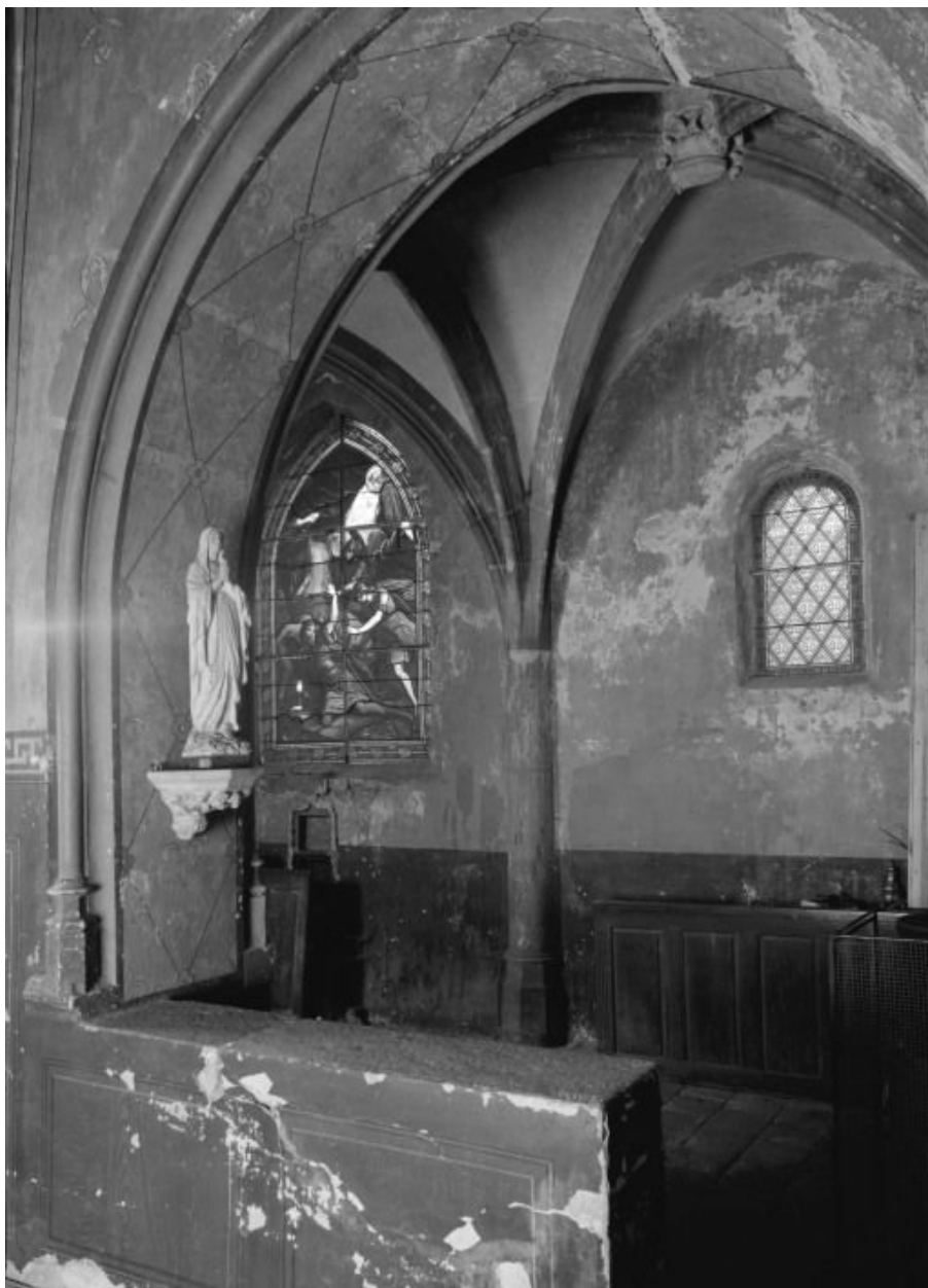
Chapelle latérale, première travée
