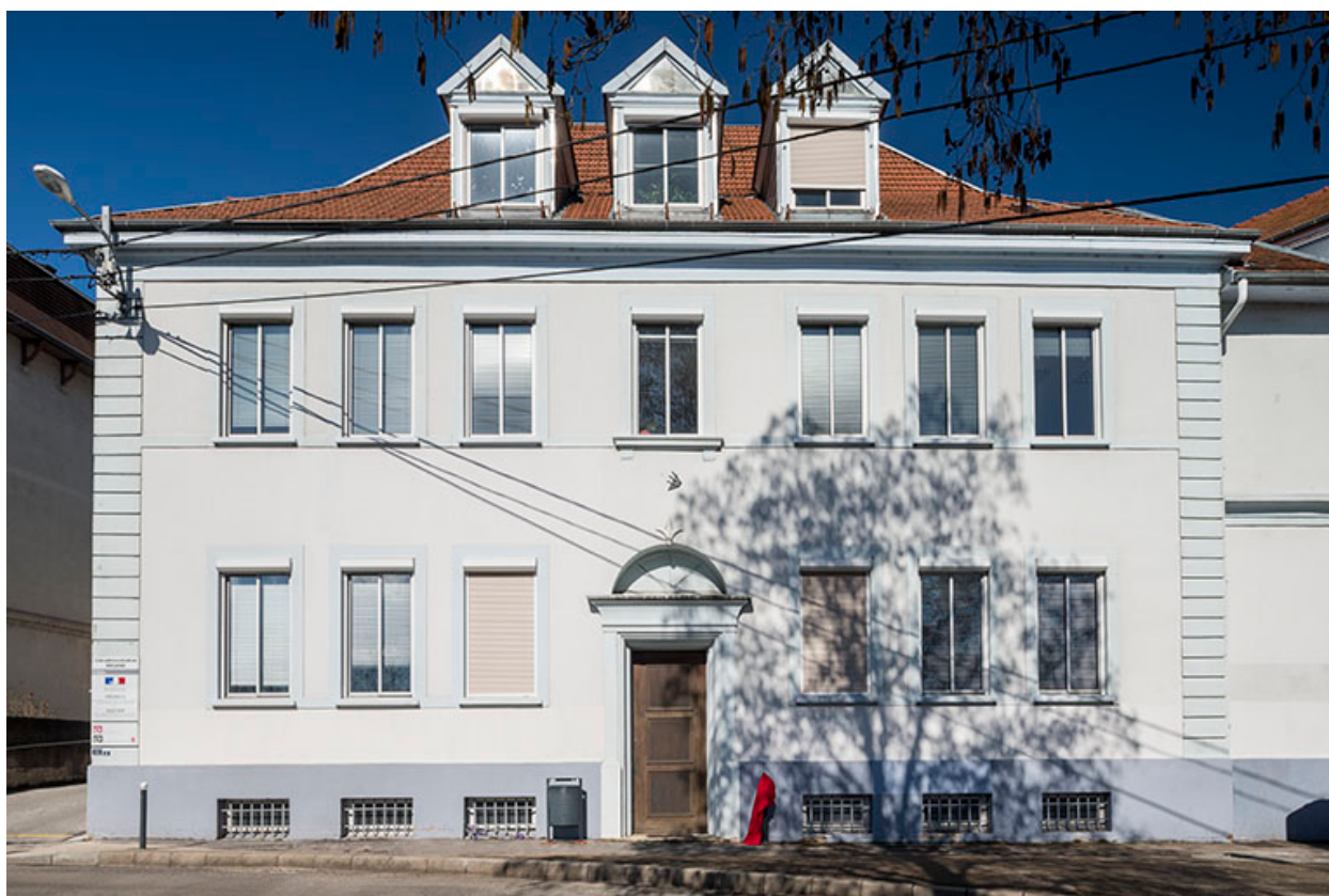
Façade antérieure des bureaux.
