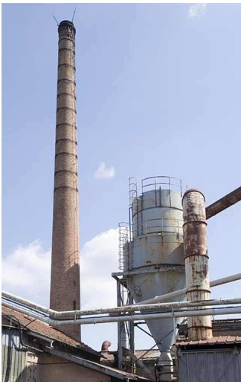
Cheminée et silo. Vue rapprochée.
