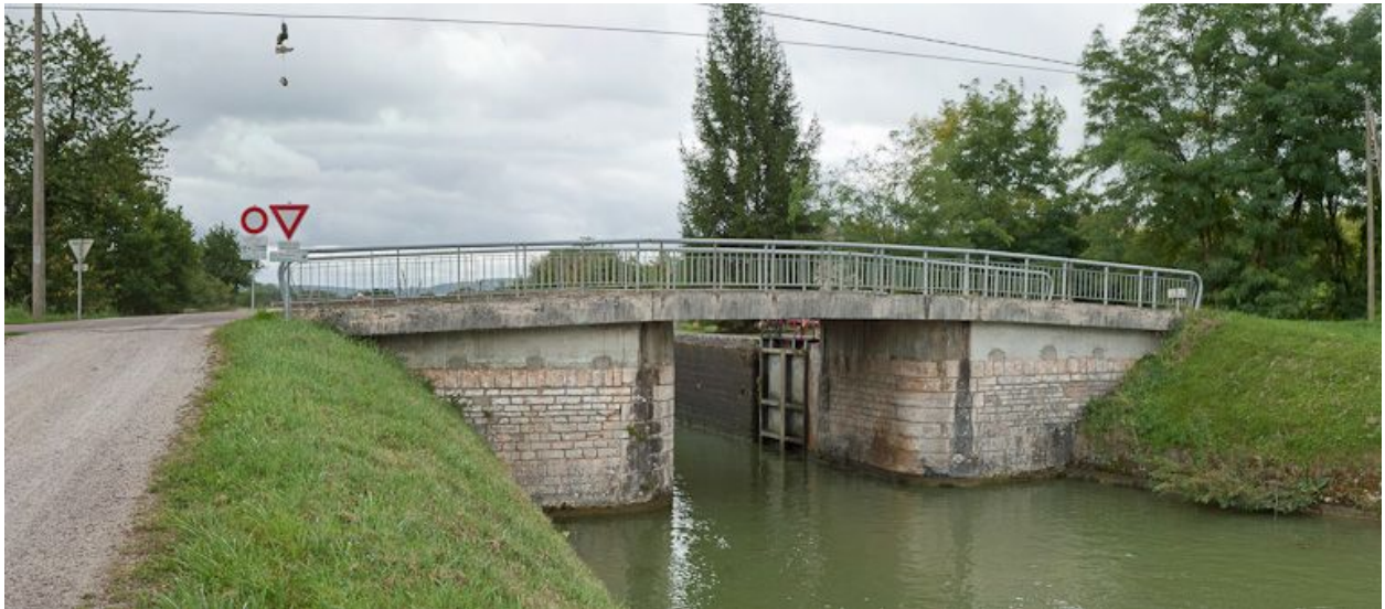
Vue du pont depuis l'aval.
