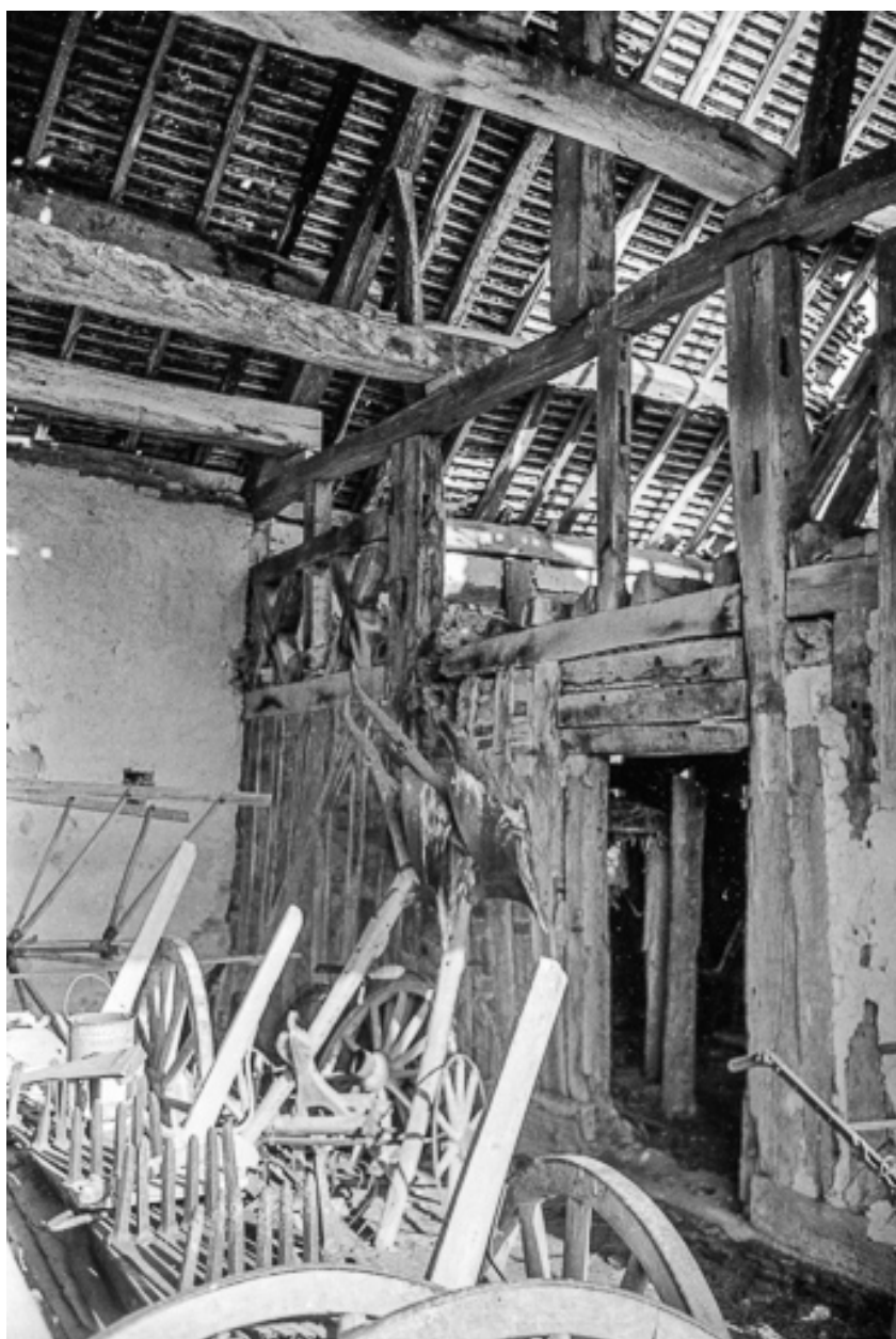
Ferme cadastrée 1956 A1 142-143 : détail de la charpente.
