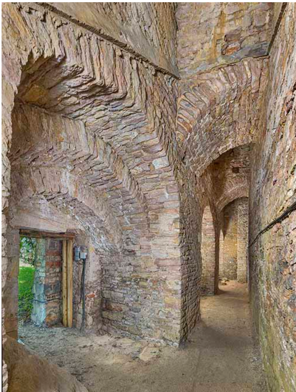
Poterne d'accès à la galerie.
