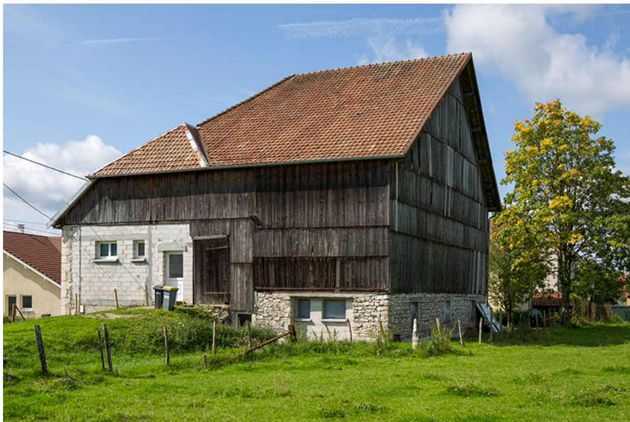
Façades latérale droite et postérieure.
