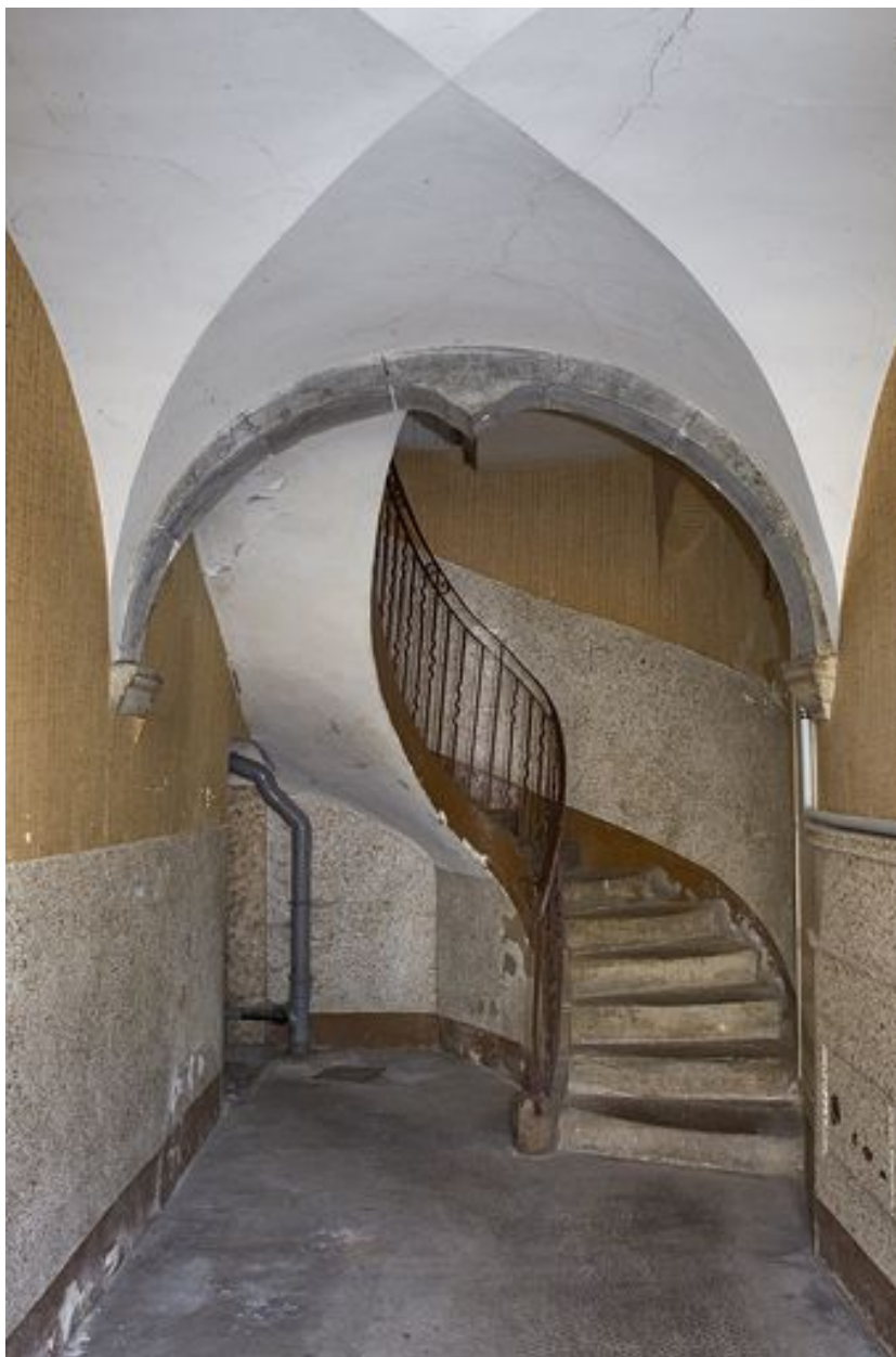
Couloir voûté et escalier.
