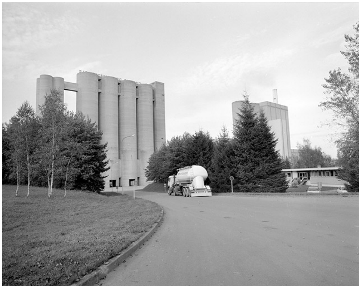
Entrée de l'usine.
